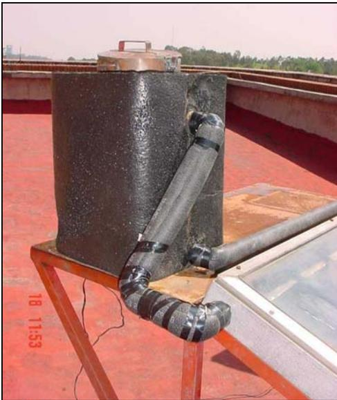
Figura #7.- Tanque de almacenamiento del fluido térmico conectado al calentador solar plano. Se aprecia la olla en el interior del tanque.
