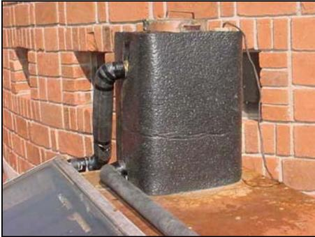
Figura #12.- Se aprecia el tanque térmico aislado junto con la olla dentro del contenedor.
